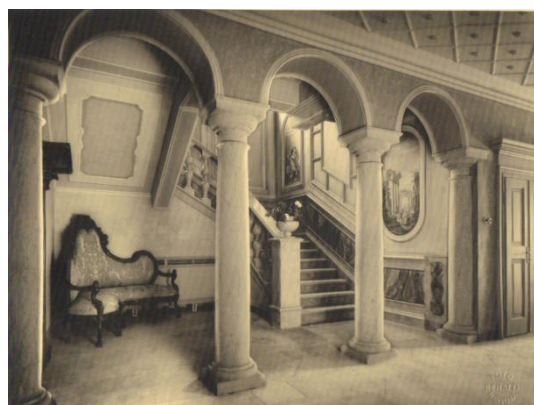
Interno della Villa negli anni '40
