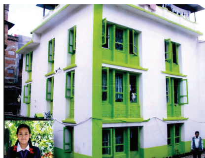
Foto sopra: l'ostello a restauro ultimato
